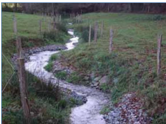
*Travaux de reméandrage avec recharge, réalisés sur la Vrillère, dans le cadre du précédent programme de travaux réalisé par le syndicat du bassin de l'Aron.*
