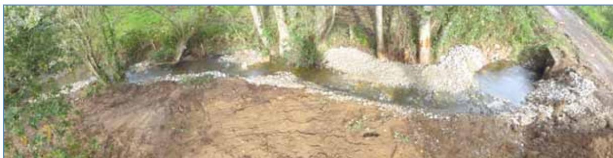
*Exemple d'aménagement d'une chute au niveau d'un pont par réalisation d'une recharge granulométrique dans le cadre du programme d'actions sur le bassin versant de l'Aron (photo : syndicat du bassin de l'Aron)*
