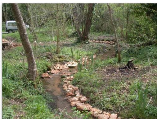
Photos ci-contre : Mise en place de banquettes de granulats sur le ruisseau des Varennes à Anché (SMCS, 2009)
