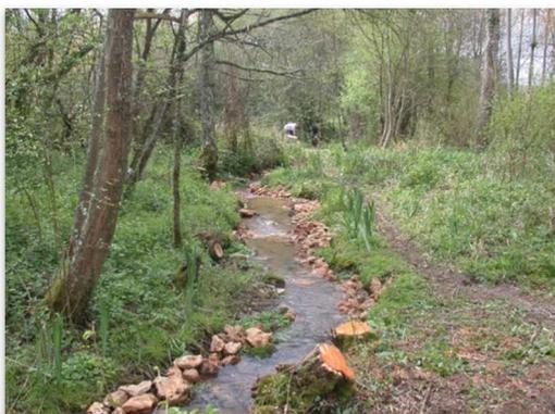
Dans une logique de redynamisme du cours d'eau, il conviendra de raisonner la taille des matériaux à la capacité de charriage de celui-ci. Sur le bassin, on privilégiera les granulats de type gravillons de 8 à 12 mm, et les pierres rondes de 1 à 13 cm (SERAMA, 2010).
