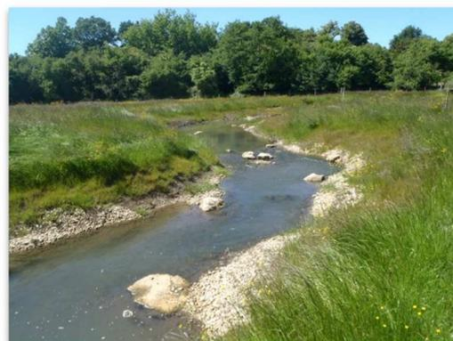
Photo à droite : Renaturation d'un bras de contournement de la Clouère (NCA, 2013)
