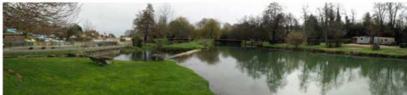
Vue d'ensemble de l'amont vers l'aval du site
