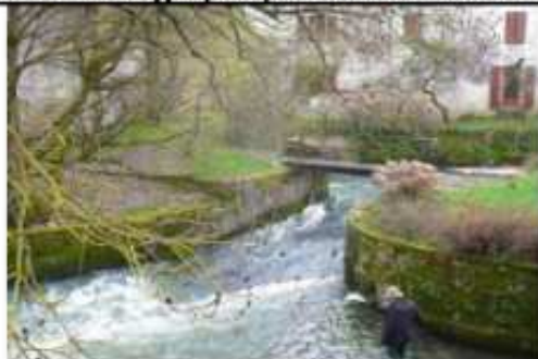
Clapet vue du pont
