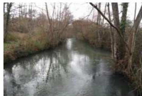
Vue amont clapet (2)
