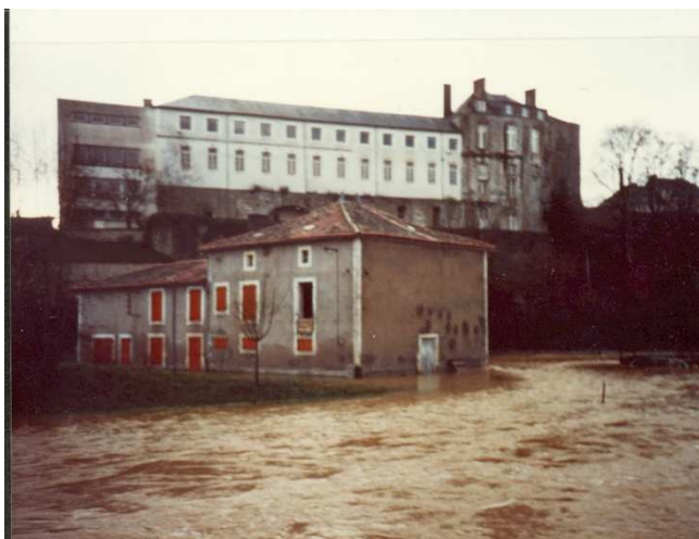
Inondation de la Dive à Couhé (déc. 82)
