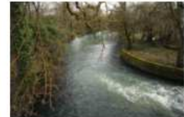
Vue aval Bief (3)
