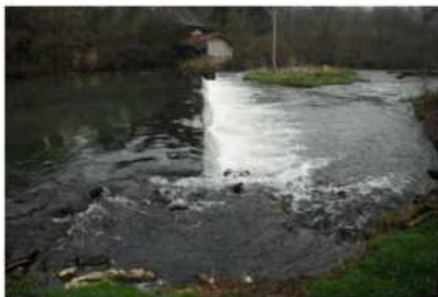
Déversoir F avec brèche
