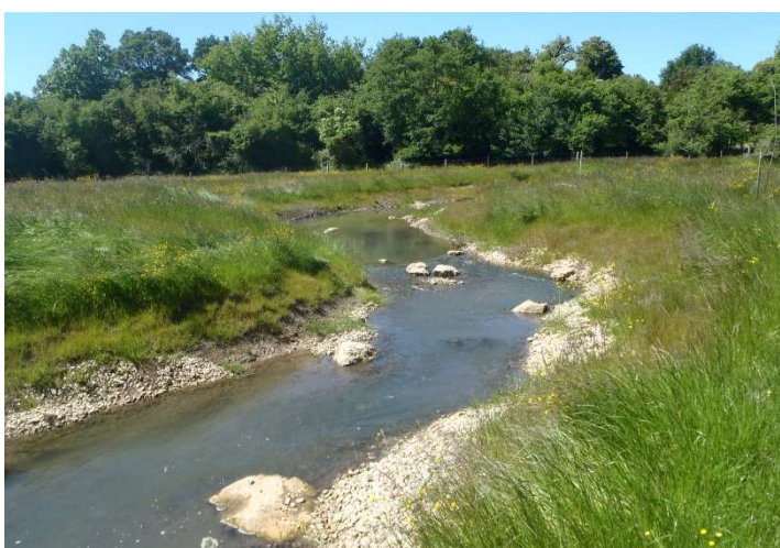
Photo 8 : Renaturation d'un bras de contournement de la Clouère à Brion (NCA 2013)
