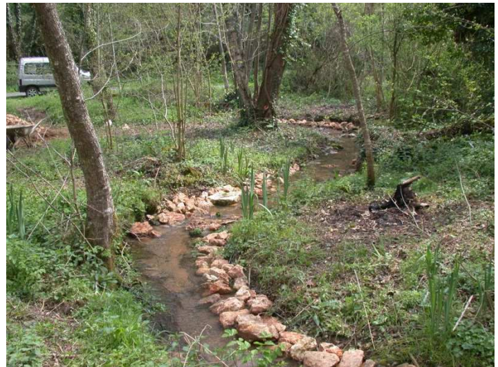
Photo 4 et 5 : Mise en place de banquettes de granulats sur le ruisseau des Varennes à Anché (SMCS 2009)
