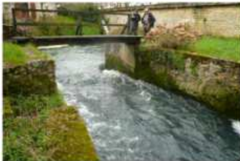
Clapet vue de l'aval
