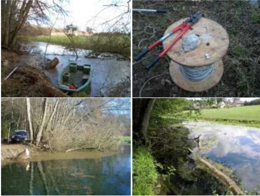
Photo 11, 12, 13, 14 : Pose d'un arbre câblé à Couhé, Abbaye de Valence en 2012 (Dive de Couhé)
