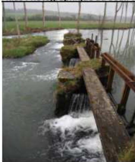
Vannage B et C
