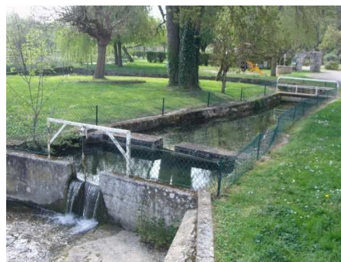
Photo : dv_210410_31 : passage à équiper pour le franchissement
