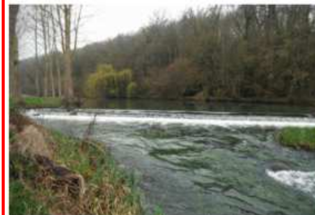
Déversoir F vue de l'aval
