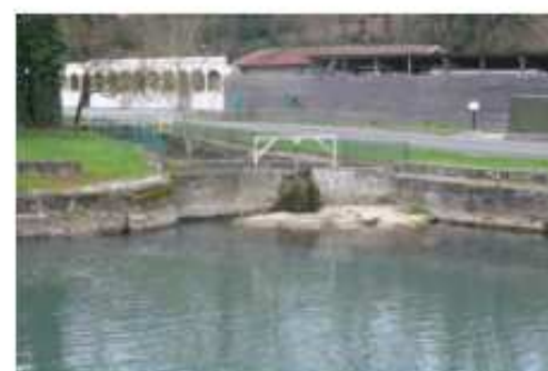
Vanne A vue de l'îlot
