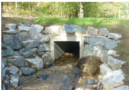
Avant la mise en place des travaux, concertation avec les techniciens de l'Agence Française de la Biodiversité, le propriétaire du terrain
