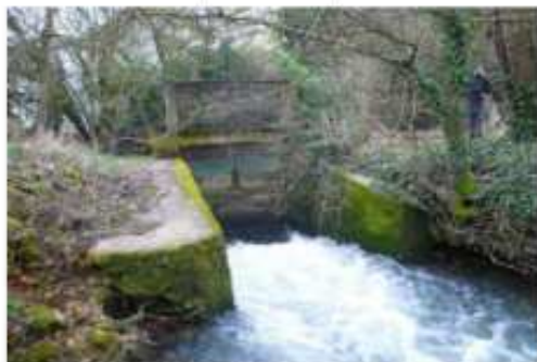
Vanne B vue de l'aval
