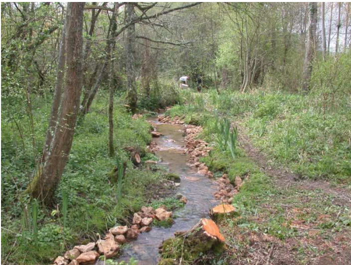
Photo 4 et 5 : Mise en place de banquettes de granulats sur le ruisseau des Varennes à Anché (SMCS 2009)
