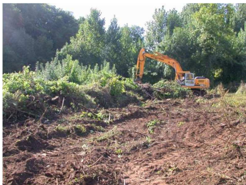
Photo 43 : Abattage et nettoyage d'une ancienne peupleraie sur la Dive à Couhé (sept. 10)
