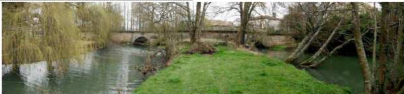
Passage des 2 bras sous le pont de la N10 + îlot
