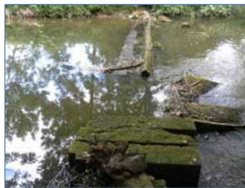
Vue de l'ouvrage amont
