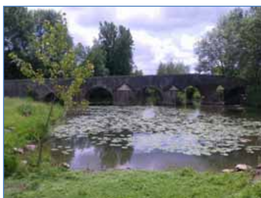
Vue du pont de Curzay-sur-Vonne
