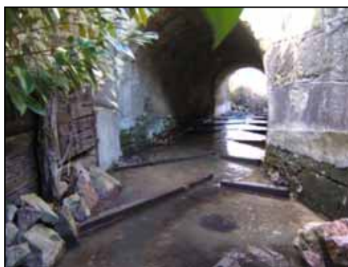
Vue du radier du pont présentant une lame d'eau faible et une chute aval et implantation des barrettes offset par l'AAPPMA la Truite de l'Huisne (61) après recharge en granulats en aval
