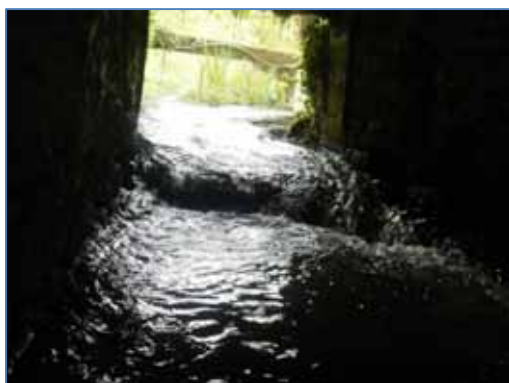
Vue du pertuis de décharge de rive droite avec une chute amont de 0.25 m et une chute aval de 0.4 m.
