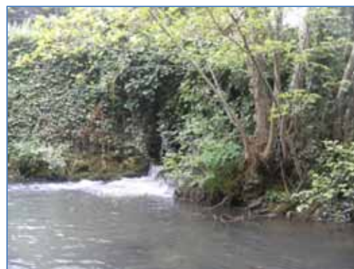
Vue du pertuis de décharge de rive droite avec une chute amont de 0.25 m et une chute aval de 0.4 m.
