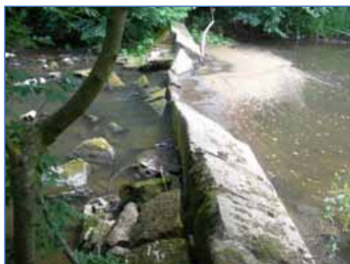
Vue de l'ouvrage aval
