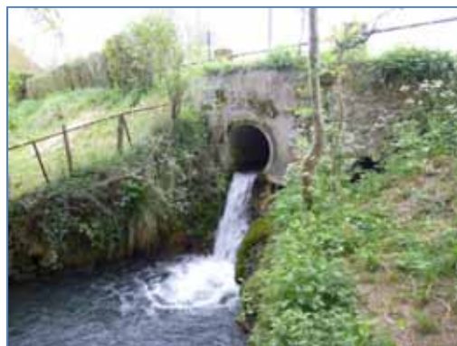
Vue du passage busé de la route communale (ancienne digue).
