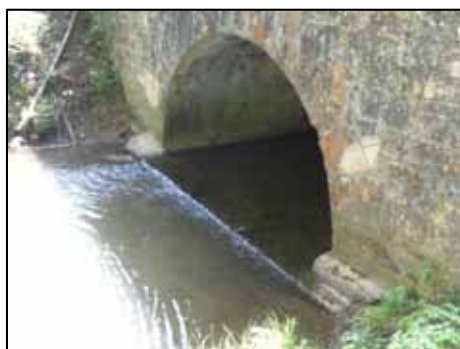
Pont de Monpapan (D94) sur la Chaussée (commune de Sanxay)
