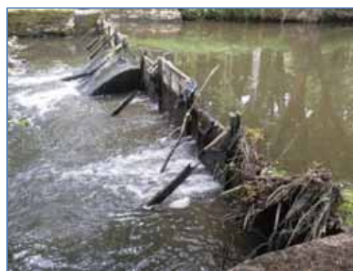
Vue de l'ouvrage
