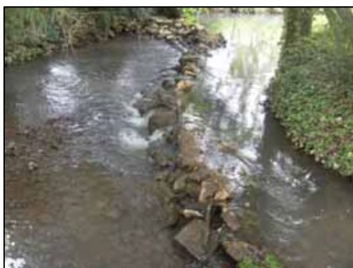
Seuil répartiteur de Sais sur le Palais à Vivonne alimentant un bras dans les jardins
