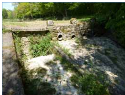
Vue de la digue empierrée et de l'ouvrage de trop-plein depuis l'aval.
