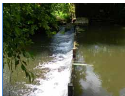
Vue de l'ouvrage
