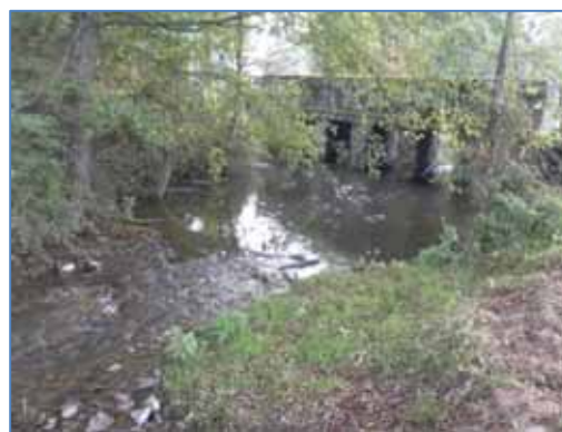
Exemple d'aménagement d'une chute au niveau d'un pont par réalisation d'une recharge granulométrique en aval sur le Thouaret dans les Deux-Sèvres
