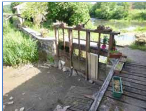
Vue du déversoir de décharge amont et des vannes de décharge au niveau du moulin en mauvais état.
