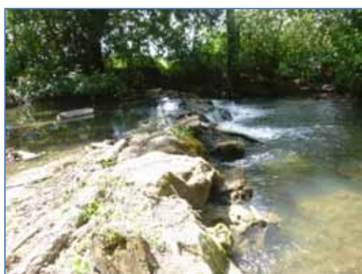
Vue du seuil en enrochements
