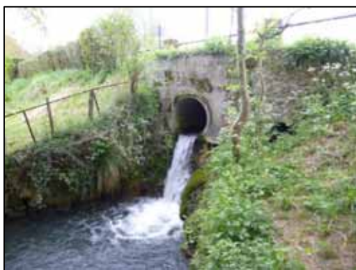
Passage busé de la route communal de Bossard (commune de Cloué) sur le Gabouret, un nouveau pont est proposé en lien avec un projet de remise dans le talweg
