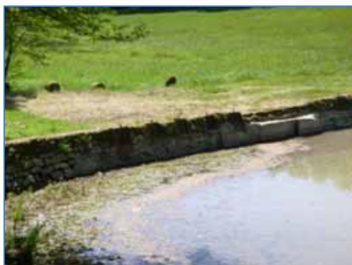
Vue de la digue empierrée et de l'ouvrage de trop-plein depuis l'aval.
