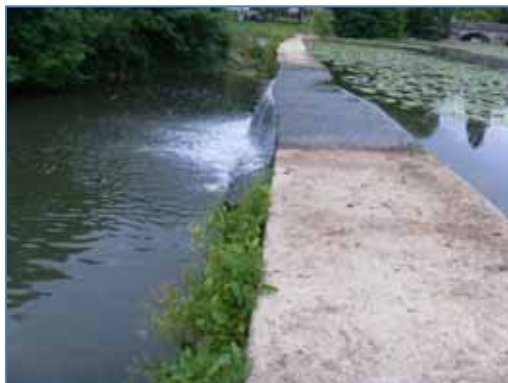
Vue du déversoir de décharge et de la passe à anguille hors d'eau.
