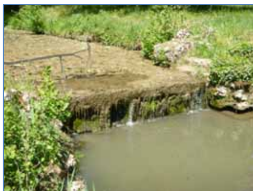
Vue de l'ouvrage aval depuis l'aval
