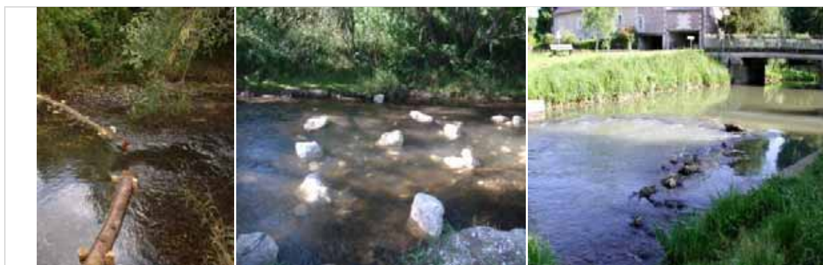
Exemple de travaux réalisés sur la Brenne (37) – Photos : Fabien Languille : déflecteurs en bois, dispersion de blocs sur un radier, création d'un mini-seuil
