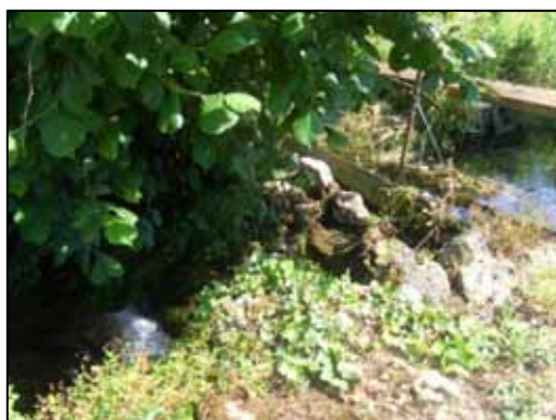
Vue d'un ouvrage permettant de caler la ligne d'eau au niveau de potagers sur le Bousseron (commune de Lusignan).
