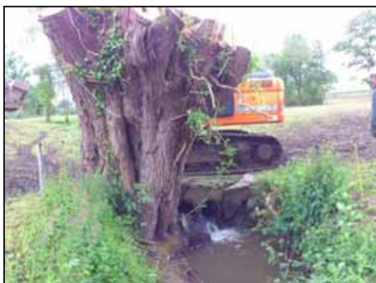
Exemple de remplacement d'un passage busé et mise en place d'une buse PEHD coupée par la moitié dans le sens de la longueur sur le ruisseau du Gué Chanceaux (61)
