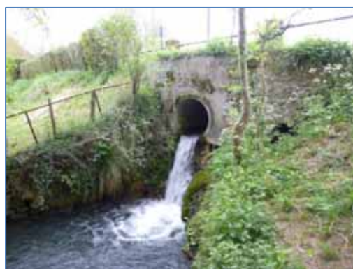
Vue du passage busé de la route communale (ancienne digue).
