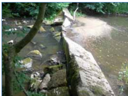
Vue de l'ouvrage aval
