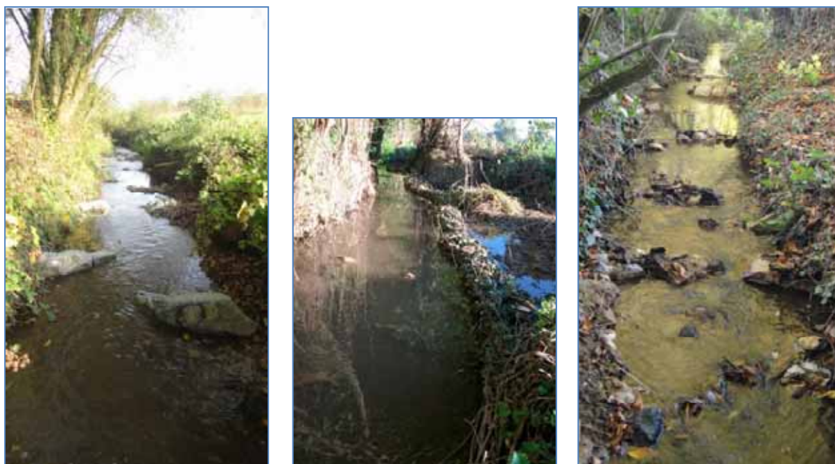
Photographie des travaux de renaturation réalisés dans le cadre du programme du syndicat de bassin de l'Aron, en partenariat avec le chantier d'insertion de Villaines-la-Juhel.
