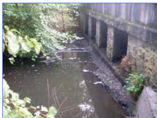
Exemple d'aménagement d'une chute au niveau d'un pont par réalisation d'une recharge granulométrique en aval sur le Thouaret dans les Deux-Sèvres
