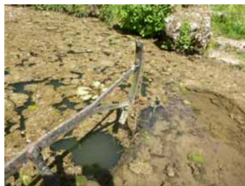
Vue du développement d'algues filamenteuses dans le lit de la Rune lié à la présence de l'ouvrage et à l'ensoleillement
