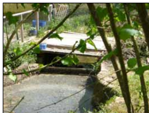
Remplacement d'un batardeau par des mini-seuils au niveau du Moulin Garnier sur la Rune (commune de Marçay)
