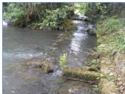
Vue du pertuis de décharge de rive gauche ciblé pour les aménagements avec un dénivelé global de 0.55 m et la présence d'un système racinaire en amont (photo de gauche).
