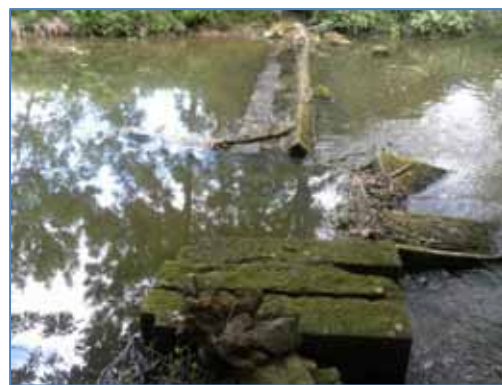
Vue de l'ouvrage amont
