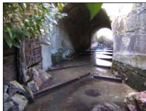
Vue du radier du pont présentant une lame d'eau faible et une chute aval et implantation des barrettes offset par l'AAPPMA la Truite de l'Huisne (61) après recharge en granulats en aval
