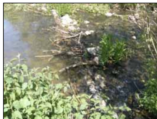
Vue d'un seuil sur la Chaussée au niveau de la Paragère (commune de Curzay-sur-Vonne).
