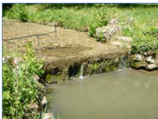
Vue de l'ouvrage aval depuis l'aval
