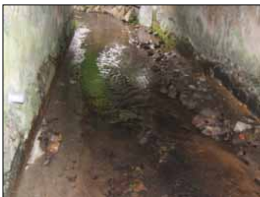
Vue du radier du pont présentant une lame d'eau faible et une chute aval et implantation des barrettes offset par l'AAPPMA la Truite de l'Huisne (61) après recharge en granulats en aval
