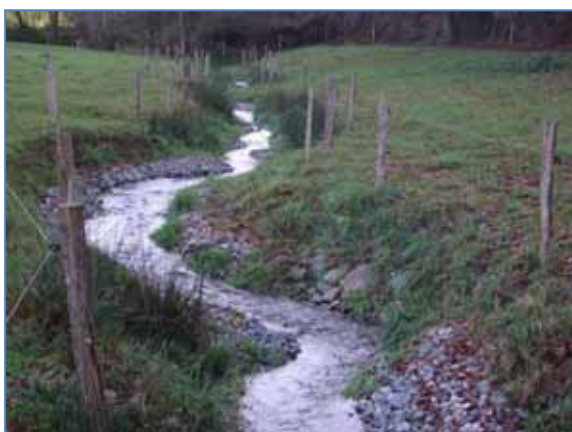
Travaux de reméandrage avec recharge, réalisés sur la Vrillère, dans le cadre du programme de travaux réalisé par le syndicat du bassin de l'Aron.
