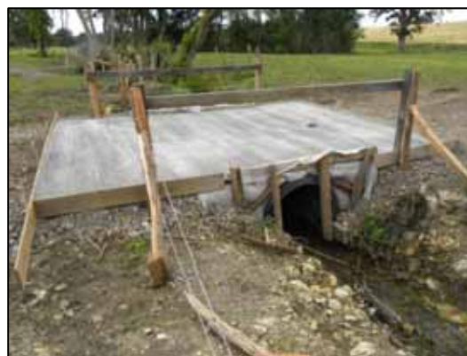
Exemple de remplacement d'un passage busé et mise en place d'une buse PEHD coupée par la moitié dans le sens de la longueur sur le ruisseau du Gué Chanceaux (61)
