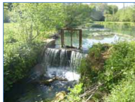
Vue des ouvrages de gestion du plan d'eau
