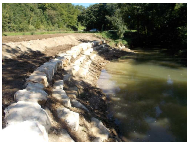
A gauche travaux de confortement de berge et diversité d'habitat au Grand Pin (pierres et transports fait par l'agriculteur) ; à droite restauration de la berge à la lagune (pierres et matériaux assurés par la commune). Merci aux élus et aux employés communaux.
